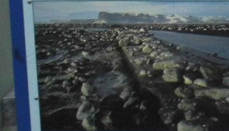
Mynd: Ragnar Árnason Hort í áttina til Lónagnipóls að brúna Hlaupi. Vífur stóð lítt eftir af fjórhöggunum um vestrari velli að Hlaupavátri. Á þessum 22,8 km vegi frá Hlaupavátri að Skálafellavegi myndfótast 6,4 km, miklar skemmdir voru á 5,3 km, lítil skemmdir á 0,7 km og 0,2 km um Skálafellavegi. The view towards the mountain Lónagnipól after the flood. In many places there was not much left of the main road across the sands. Of the 22,8 km long road from Hlaupavátri til Skálafells 6,4 km were destroyed, 5,3 km were seriously damaged, little damage occurred to 0,7 km and 0,2 km remained undamaged.
