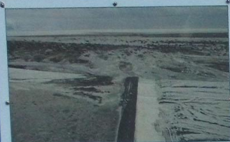
Mynd: Vaggarðinn Hlaupin í Gígukvísl söpá burtbrámi og klípti veginn í sundur á stórum kafla. The flood in the river Gígukvísl swept the bridge away and washed away a large section of the road.
